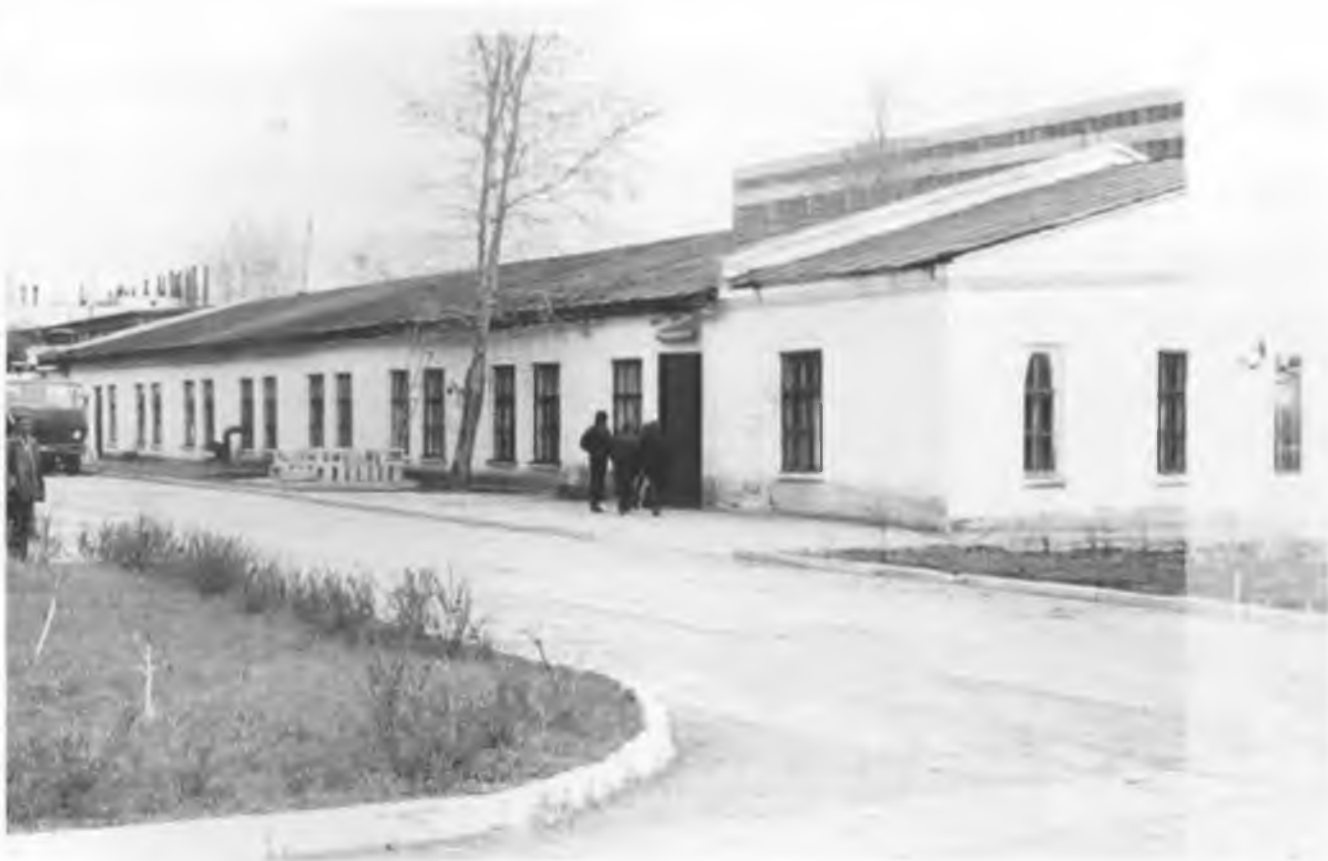
В этом здании размещался цех №4, где в 1961 году выпускались блоки УЖВ и РКЗ. Фото 1981 года. Теперь здесь инструментальный цех
