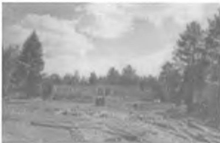
Начало строительства пионерского лагеря «Сосновый бор», 1957 год
