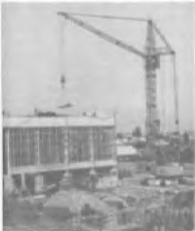
Строительство корпуса механико-заготовительных цехов
