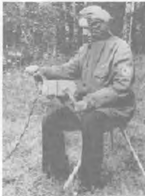
Агрегат электрический ГИП-5 («Солдат-мотор» с ручным приводом)
