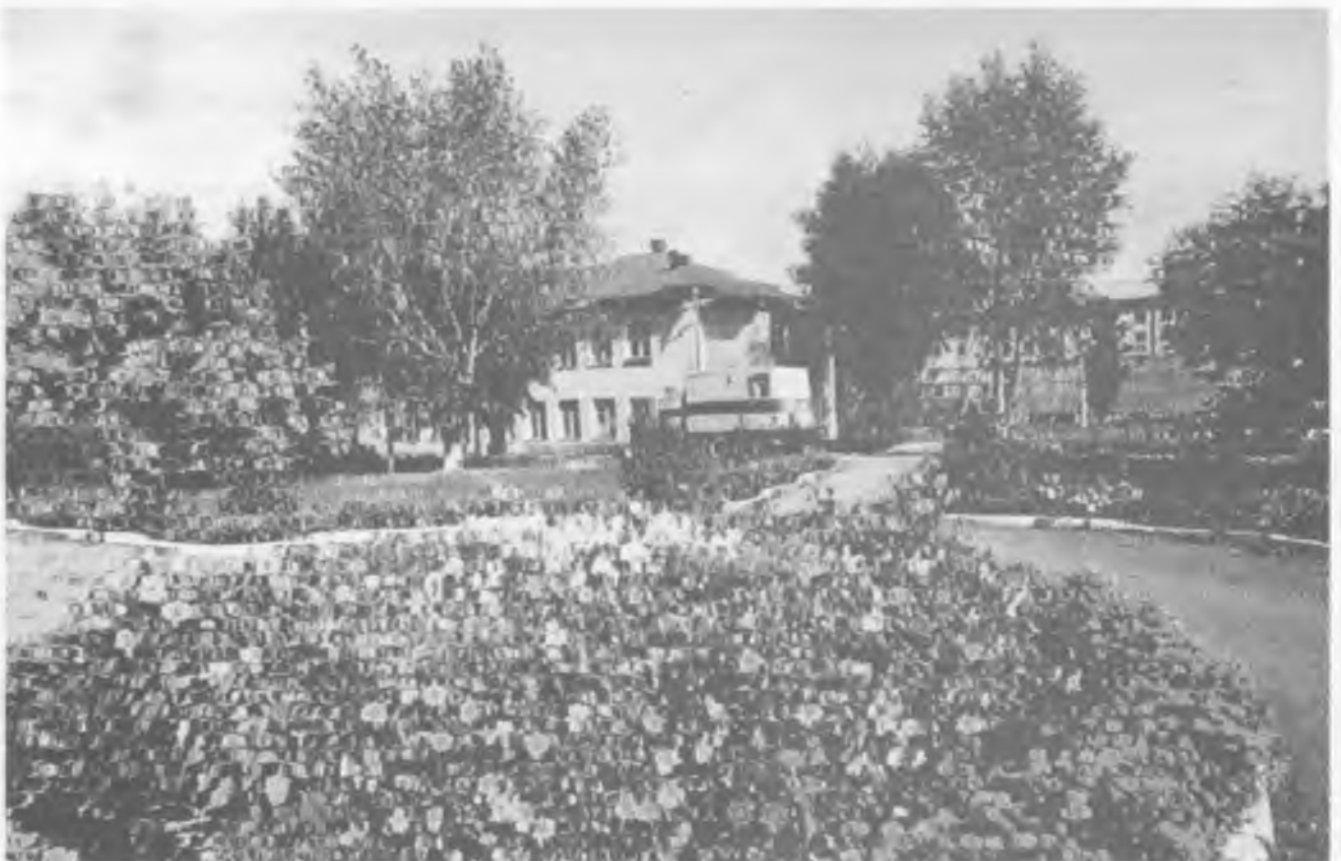
На переднем плане заводская поликлиника. На дальнем плане тепличное хозяйство и заводское общежитие по ул. Свободы, 42. Фото 1980-х годов
