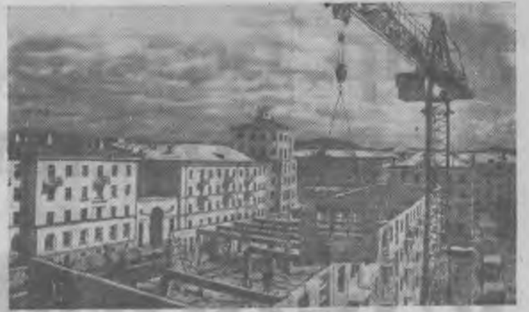
ВОСТОЧНО-КАЗАХСТАНСКАЯ ОБЛАСТЬ. В Усть-Каменогорске быстрыми темпами сооружаются жилые дома. Широко применяется прогрессивный метод строительства: возведение зданий из сборного бетона. НА СНИМКЕ: строительство крупнопанельного сборного дома на проспекте имени Ленина.
