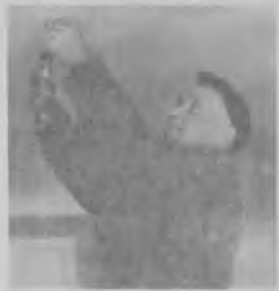
На 12-квартирном доме по улице Почтовой электрики Артемовского стройуправления приступили к проводке освещения.
