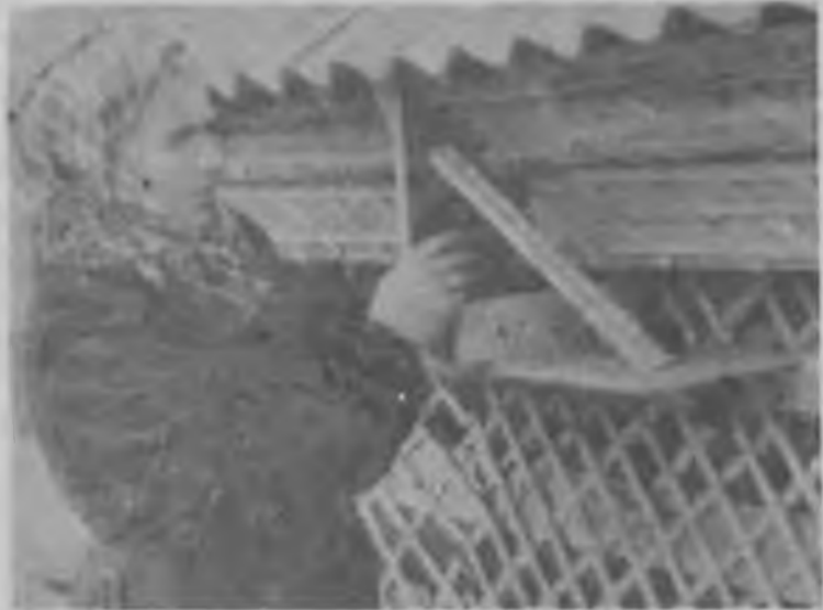
Как только плотники поставили леса, штукатуры приступили к своему делу. НА СНИМКЕ: Зоя Степановна Изотова готовится тянуть карниз на здании будущего обувного магазина в гор. Артемовском.
