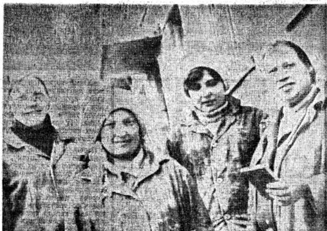
Эти женщины строят жилые дома в поселке имени Кирова. Все они по профессии штукатуры-маляры. У них опытный бригадир, кандидат в члены КПСС Галина Семёнова Боровикова. В коллективе межхозяйственной передвижной механизированной колонны эта бригада — одна из лучших.
