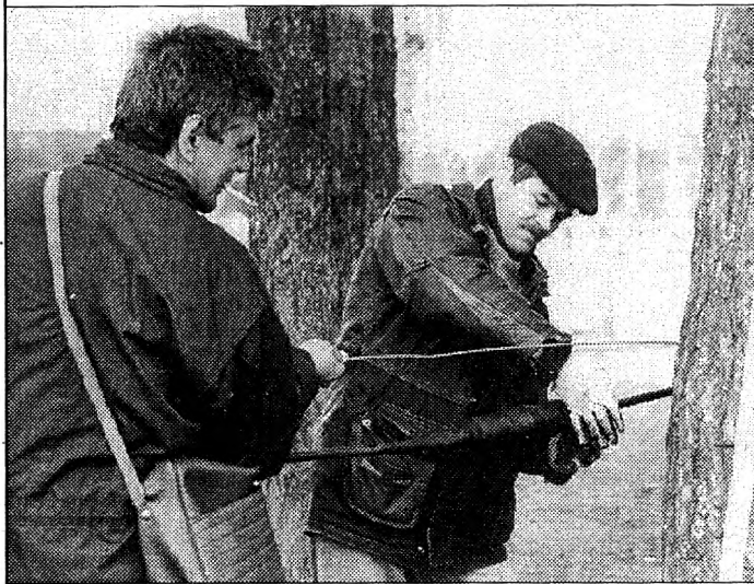
На снимке: кабельщики-спайщики восстанавливают кабельную линию в районе стадиона "Машиностроитель".
