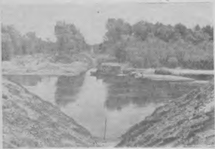
Горячие дни на строительстве газопровода Бухара—Урал. Его трасса вплотную приблизилась к Орску, предприятия которого уже в конце августа получат газ. Строительное управление №1 треста «Востокнефтепровод-монтаж» готовится к важной операции — прокладке нитки трубопровода по дну реки Урал. На месте, где газопровод пересечет реку, работают водолазы, электромонтеры, монтажники, действуют земснаряды.
