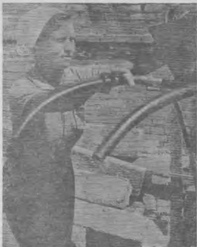
Отлично трудится на строительстве кислородной станции подсобная рабочая ОКСа Артемовского машиностроительного завода Зинаида Гончарова.
