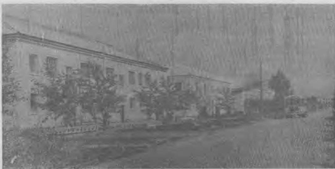
Все больше и больше строится в городе Артемовском жилых домов. Особенно это заметно по улице Физкультурников, на которой строятся дома для рабочих машиностроительного завода. Вот и сейчас в новом доме ведутся штукатурные работы — по-
