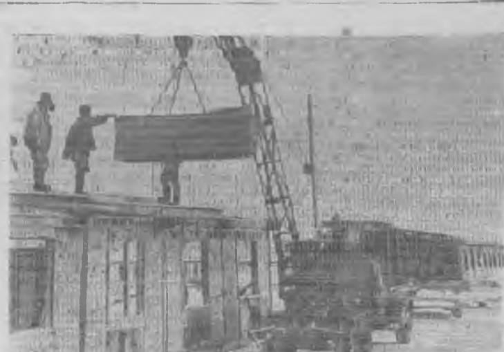
Строительство птичника на усадьбе птицефермы седьмого отделения завершается. Построено семь корпусов. Десять человек участвует в этом приложении строители мажоранта, первого и девятого отделений, чуговолитейного завода. Но достройка последних корпусов задерживается из-за отсутствия кровельного материала. В первых выстроенных птичниках уже размещено несколько тысяч утят. НА СНИМКЕ: строительство птичника (снимок сделан в марте). Фото А. Мартынова.
