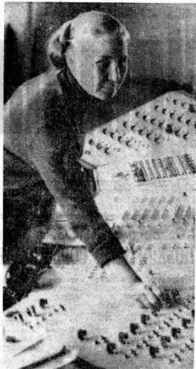
В ноябре прошлого года на станции Егоршино начал работать пост маршрутно-линейной централизации. Сейчас железнодорожный маршрут на станции открывается в считанные секунды.
