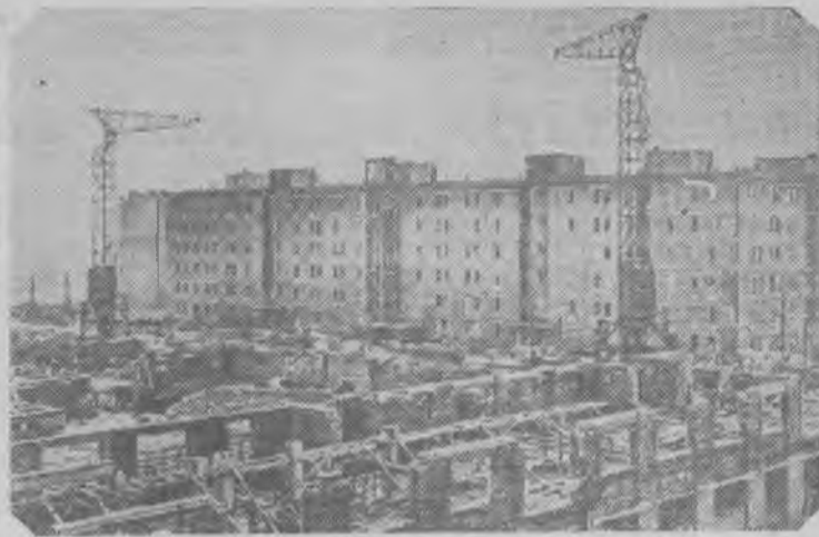
Венгерская Народная Республика. В Будапеште возводится много жилых домов. Большинство зданий строится с применением сборных деталей.
