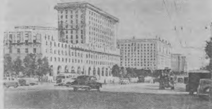
Москва. Строительство жилых домов на Ярославском шоссе.
