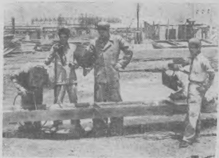
Индия. На строительстве металлургического завода в Бхилае, сооружаемого при помощи Советского Союза. Сварочные работы ведут совместно индийские и советские рабочие.
