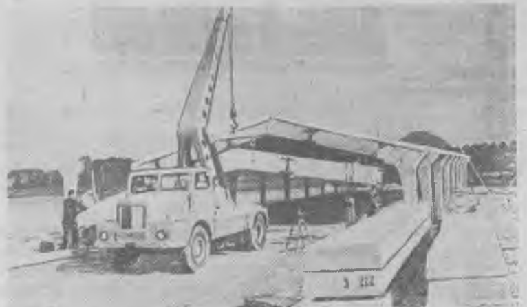
В сельских районах Германской Демократической Республики ведется строительство крупных типовых животноводческих ферм. Фермы сооружаются из крупных бетонных блоков, изготовляемых предприятиями ГДР. На снимке: строительство фермы в Брюксентце (округ Шверин). Монтажные работы ведет одно из берлинских строительных предприятий «ФЭБ-Монтажебау». На монтажной площадке используется 5-тонный автокран со стрелой 8,5 метра.
