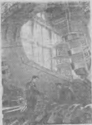
Хорошо зарекомендовали себя на крупных стройках страны землеройные гиганты — 14-кубовые экскаваторы, изготовленные коллективом Уралмашзавода. На предприятии заканчивается сборка очередного такого экскаватора — третьего в этом году. На снимке: молодые слесари-сборщики новозаказанного цеха Станислав Щербак и Владимир Федоренко собирают зубья 14-кубового ковша.
