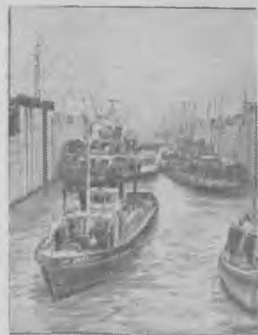
Строители Горьковской гидроэлектростанции сдали в эксплуатацию первую очередь судоводных сооружений гидроузла.
