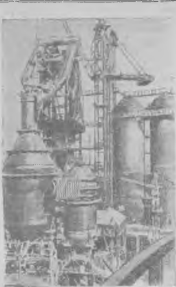
Челябинская область. Строители 4-й доменной печи Челябинского металлургического завода готовят достойную встречу XX съезду КПСС. Они обязались досрочно закончить строительство доменной печи.
