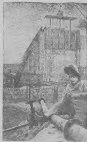
На строительстве Кременчугской ГЭС высокие производственные показатели добилась передовая бригада слесарей-монтажников управления основных сооружений Анатолия Скрипки. На строительстве воздухопровода она более чем в два раза перевыполняет задание.
