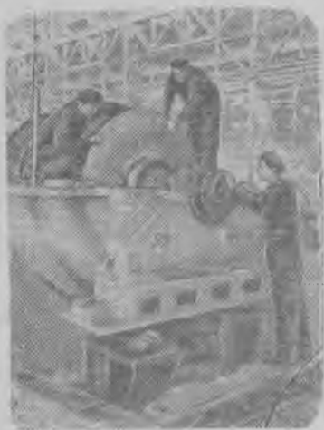
На Невском машиностроительном заводе имени Ленина изготовлен компрессор, предназначенный для металлургической промышленности, производительностью 2500 кубических метров воздуха в минуту. На снимке: сборка компрессора.
