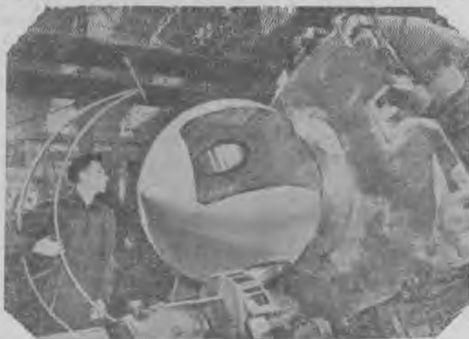
Свердловск. На Уралмашзаводе изготавливается новый мощный плагирующий экскаватор ЭП-25/100 с ковшем объемом 25 кубометров. При передвижении экскаватор не требует тщательного выравнивания грунта. Каждый опорный башмак у него сможет принимать уклон до 10 градусов. Это стало возможным благодаря применению опоры шарового типа, разработанной инженерами завода.
