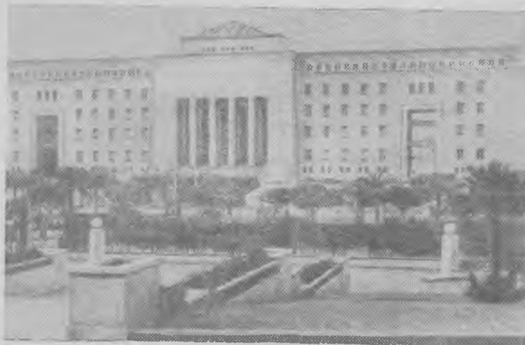
Объединенная Арабская Республика. На снимке: здание инженерного факультета Александрийского университета.
