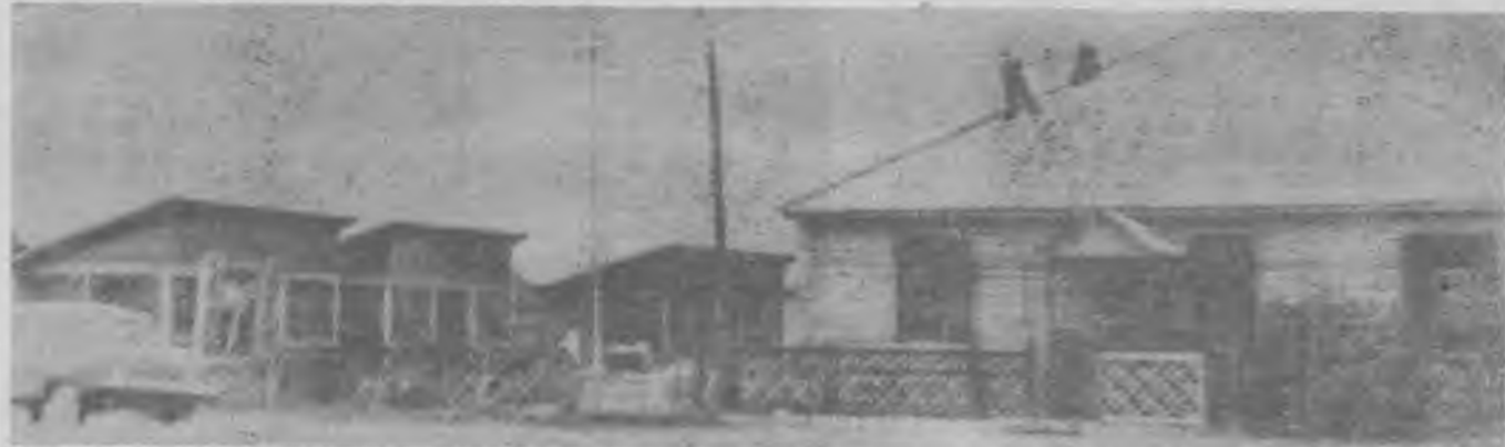
По улице Физкультурников на месте бывшего Дома пионеров в Артемовском построено новое большое и светлое здание детсада. Скоро в нем зазвонят голоса юных артемовцев.
