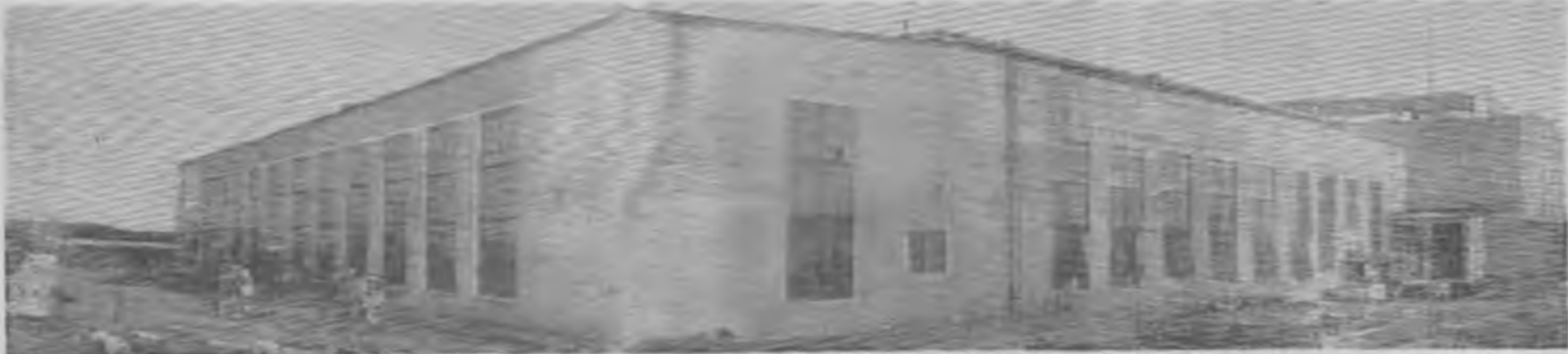
Блок вентиляторных цехов Артемовского машиностроительного завода.
