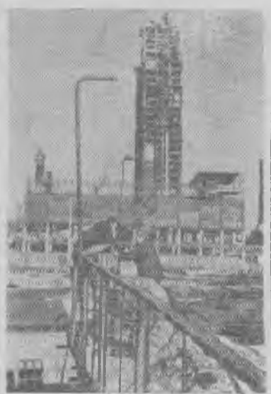
В Грозном завершается строительство установки непрерывного контактного коксования (Г-18). На этой установке из тяжелых крекинг-остатков битума и пека будут производиться бензин, дизельное топливо и электродный кокс. На снимке: электрики ведут электромонтаж установки „Г-18“
