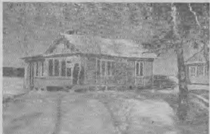
В поселке Усово Московской области построено несколько новых каркасных домов, главная особенность которых — исключительная простота изготовления и легкость сборки. На снимке: трехкомнатный одноквартирный жилой дом из пресбетонных элементов.
