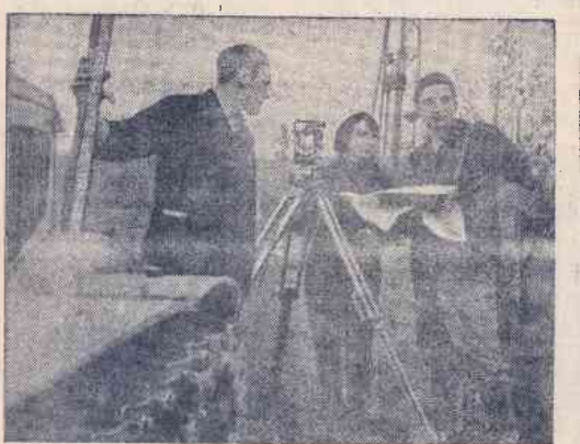
Коми АССР. Печорская ГРЭС, первоначальная мощность которой составит 1200 тысяч киловатт, будет сооружена возле города Печоры. Сейчас сотрудники Рижского отделения Всесоюзного института «Теплоэлектропроект» ведут изыскания на месте будущей стройки. За последние годы на севере республики разведаны крупные месторождения нефти, природного газа, алюминиевого сырья, калийной соли, строительных материалов. Ввод в строй большого энергетического узла позволит освоить природные богатства тайги и тундры, создать на европейском Севере страны новый промышленный комплекс. На снимке: изыскатели (слева направо) Виктор Глумов, Нина Гаевская и Карл Виталиныш на месте будущей Печорской ГРЭС. Фото С. Губского. Фотохроника ТАСС.
