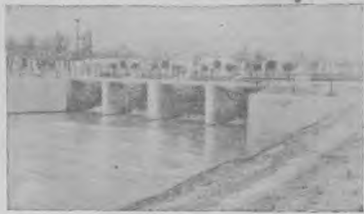
В Кизлярском районе на реке Терек вступил в строй Копайский гидроузел, который позволит оросить 200 тысяч гектаров засушливых Ногайских степей. На снимке: общий вид Копайского гидроузла.
