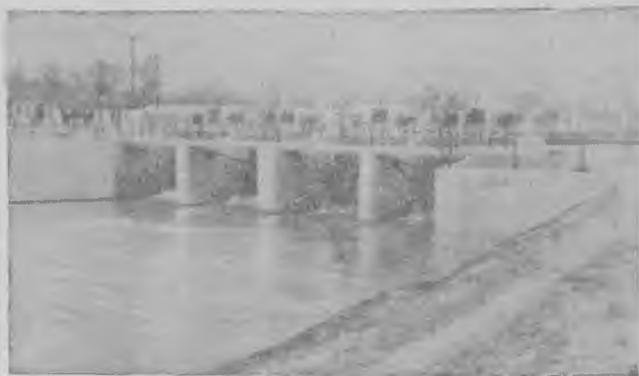
В Кизлярском районе на реке Терек вступил в строй Копайский гидроузел, который позволит оросить 200 тысяч гектаров засушливых Ногайских степей.
