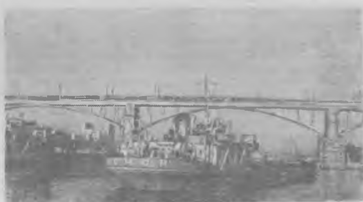
В Куйбышеве завершено строительство моста через реку Самару. На снимке: новый мост через реку Самару. Фото Н. Финикова. Прессклише ТАСС
