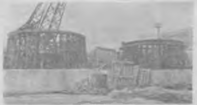
Горьковская область. В конце этого года на Горьковской гидроэлектростанции должна быть пущена в эксплуатацию первая турбина.
