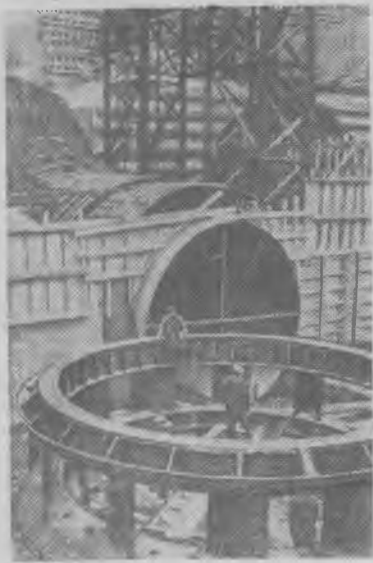
Строители Братской ГЭС установили в проектное положение статор первого гидроагрегата.
