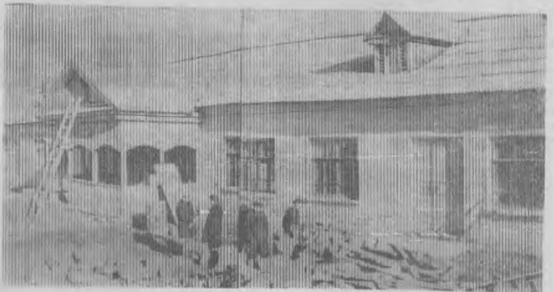
Здание мастерских училища, построенное в 1960 году силами коллектива горнопромышленного училища № 1.
