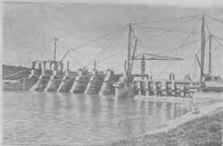
Молдавская ССР. На строительстве Дубоссарской ГЭС закончено сооружение плотины и начался один из наиболее ответственных этапов работы — затопление котлована.
