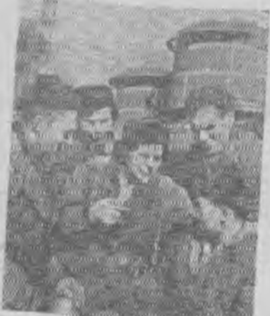
Пуганская область. На Алчевском металлургическом заводе имени Доргошилова содружество крупная ломаная печь. Это — ударная комсомольская стройка. На снимке: группа строителей Пуганской комсомольской лампы.
