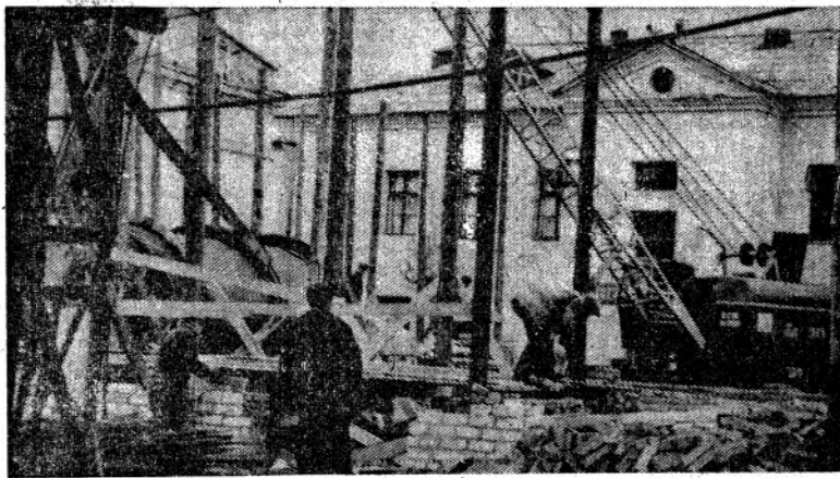
НА СНИМКЕ: монтаж подъемной установки на шахте Була наш-4.
