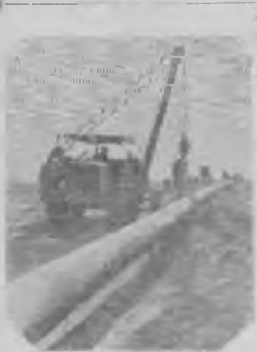
Убытки СССР. Не отменяется строительство газопровода Джаржар-Бухара — Самарканд — Ташкент заканчивается укладка труб на участке Джаржар — Бухара. Строители магистральной линии обязались в честь XXI съезда партии досрочно, к 1 ноября, дать газ Бухаре и Кагану.
