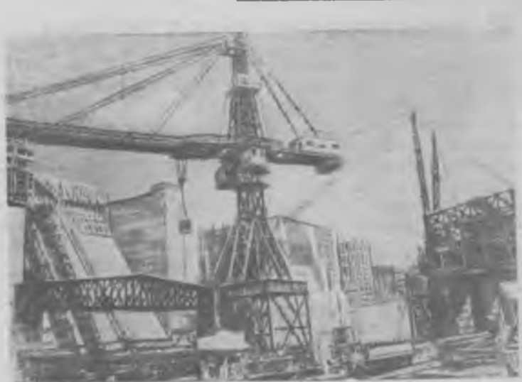
Усть-Каменогорск, Казахской ССР. На Иртыше возводится гидроэлектростанция.
