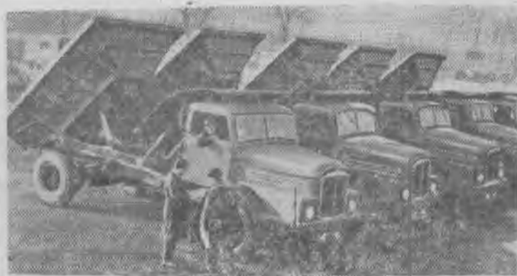
Германская Демократическая Республика. На Лейпцигскую международную весеннюю ярмарку народное предприятие «Специальфарцейгверк» в Берлине представило наряду с другими экспонатами самосвалы с обогреваемым снизу кузовом, предназначенные для транспортировки грузов в зимнее время. Полезная грузоподъемность машин — 7 тонн.
