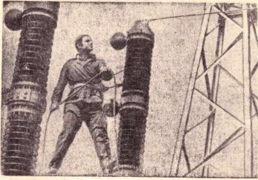
СВЕРДЛОВСКАЯ ОБЛАСТЬ. Поблизости от уральского города Асбест на берегу таинной реки Рефт сооружается крупная тепловая электростанция—Рефтинская ГРЭС. Строители, выполняя обязательства завершающего года пятилетки, заканчивают монтаж энергоблока мощностью 300 тысяч киловатт. Первый ток он даст в Уральскую энергосистему в сентябре текущего года. НА СНИМКЕ: бригадир электромонтажников М. П. Резниченко на монтаже первого энергоблока. Фото А. Грахова, Фотохроника ТАСС.
