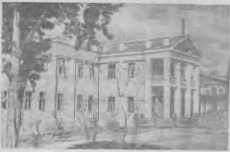
Здание треста Егоршинуголь после реконструкции. Фото А. Мартынова.
