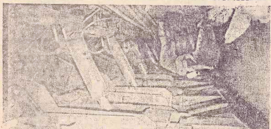
Кемеровская область. Шахты Томь-Усинского рудника реконструируются, оснащаются новыми высокопроизводительными механизмами, угольными комплексами. На снимке: новый угольный механизированный комплекс ОМКТМ на шестом участке крупнейшей в Сибири шахты «Томь-Усинская 1-2». Фото А. Кузряина, Фотохроника ТАСС
