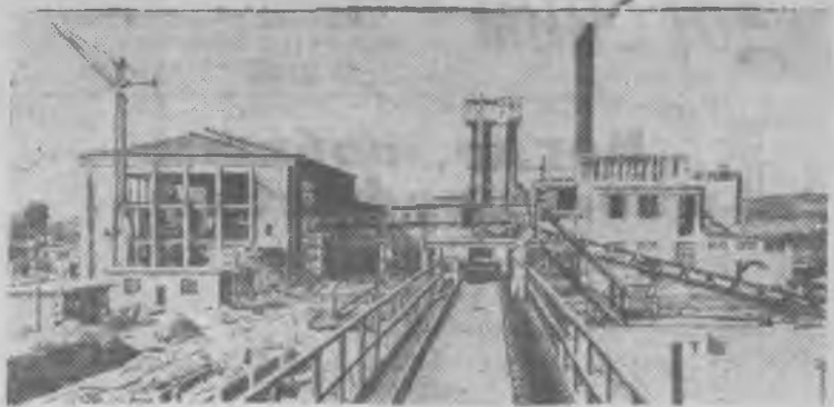
Народная Республика Болгария. Строительство сахарного завода в Ломе.
