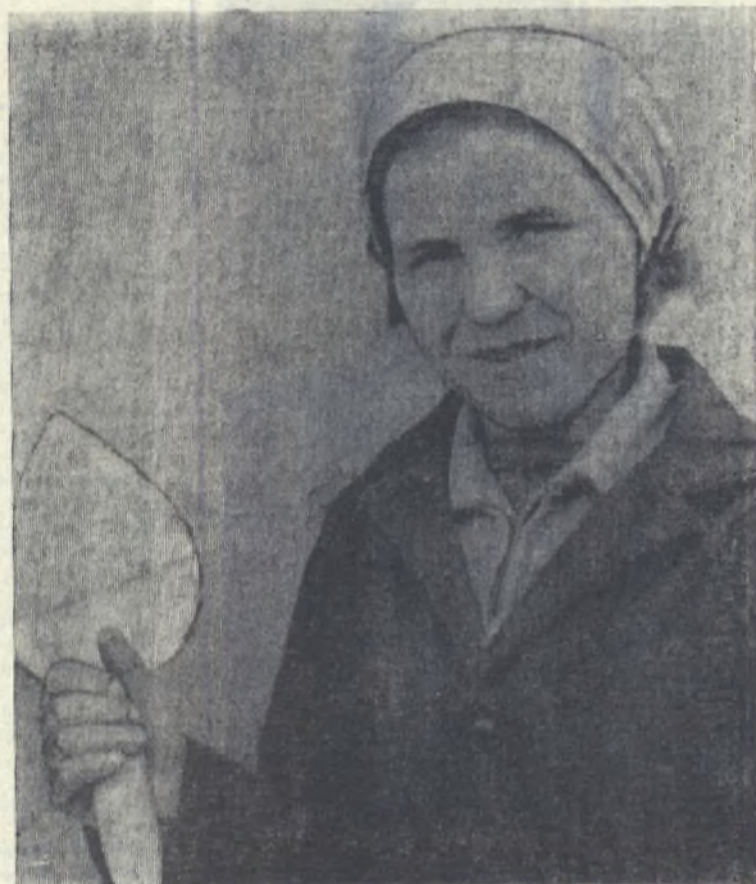
В строительном-монтажном поезде № 386 Ирина Ивановна Гусева трудится 16 лет. Сейчас она руководит бригадой, которая ведет отделочные работы на строительстве 70-квартирного дома. За свой труд Ирина Ивановна награждена значком «Отличник социалистического соревнования РСФСР».
