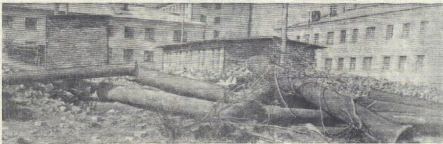
В районе строительства микрорайона № 1 после сдачи объектов в эксплуатацию.
