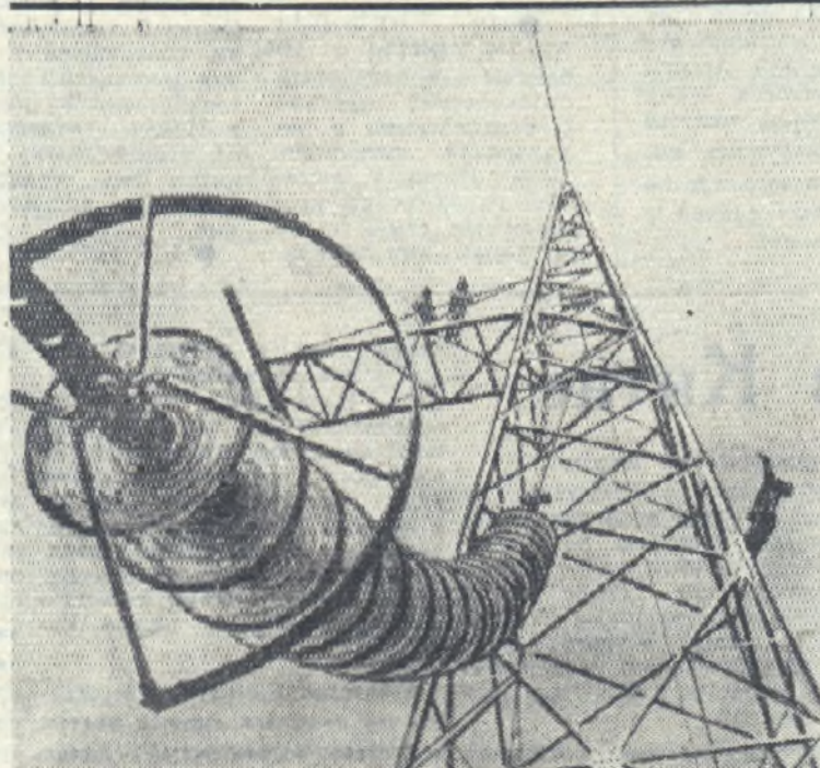
Тюменская область. Строители высоковольтной линии электропередач Тюмень — Сургут, работая в сложнейших природных условиях, уже установили 500 опор, смонтировали первые 60 километров воздушной линии и готовятся к возведению крупнейших переходов через сибирские реки Обь, Иртыш, Тобол. НА СНИМКЕ: на головокружильную высоту поднимают 500-килограммовые гирлянды изоляторов.
