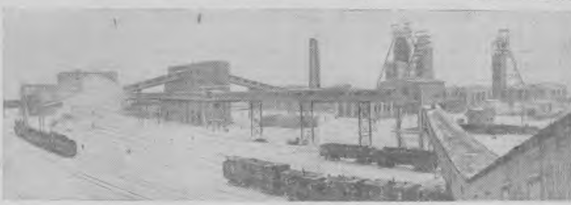
Ростовская область. Шахтостроители Дона сдали в эксплуатацию еще одну шахту — «Гуковская-1».
