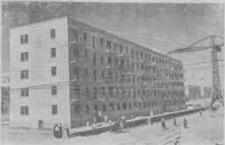
В Ростове-на-Дону на проспекте имени Ленина построен пятиэтажный 80-квартирный дом в рекордно короткий срок — за 30 дней. Дом сооружался индустриальным методом из сборного железобетона. На снимке: 80-квартирный дом, построенный за 30 дней.
