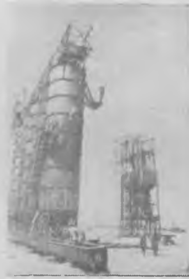
Украинская ССР. На строительной площадке Каховского гидроузла развернуто строительство подсобных предприятий. На снимке: монтаж бетонного завода на строительной площадке 2-го участка. Фото А. Фатеева. Прессклише ТАСС
