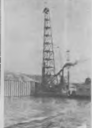
Куйбышевгидрострой. В районе сооружения котлована гидроэлектростанции началась забивка металлического шпунта перемычки, ограждающей котлован. На снимке: забивка шпунта перемычки. Фото М. Клименкова. Прессклише ТАСС
