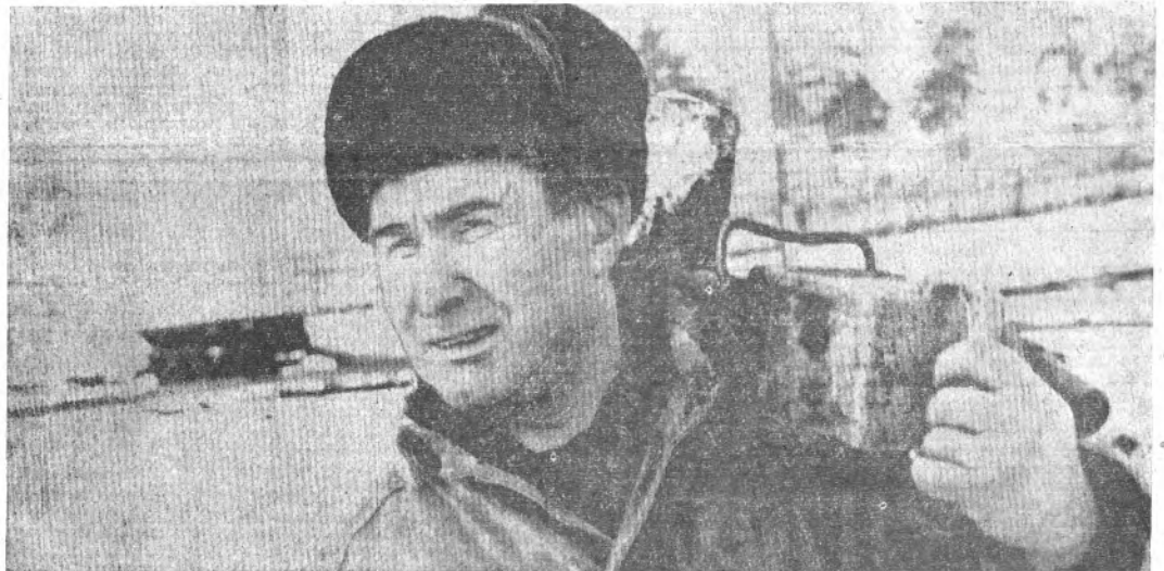
Виктор Егорович Потапов трудится в бригаде В. Е. Саплина на прокладке подъездных путей для будущего завода ЖБИ «Облколхозстрой» на территории бывшей шахты имени Кирова. Не так уж много времени прошло с начала работ, а
