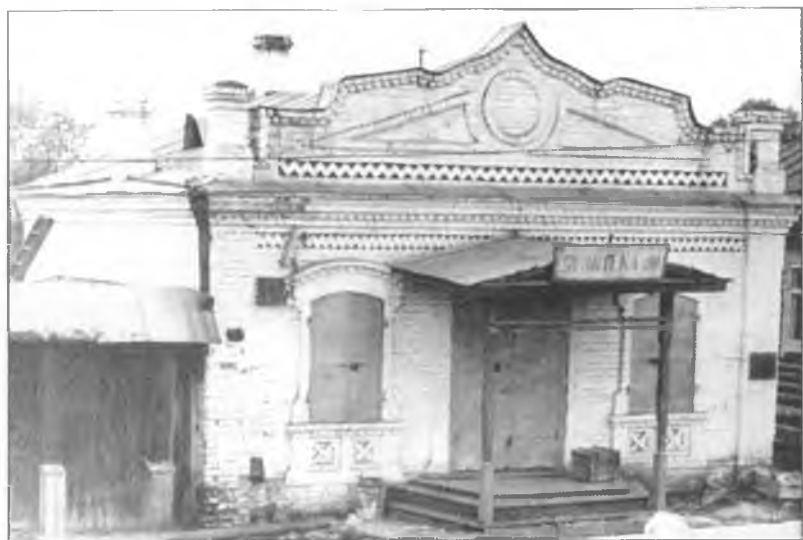
Склад 1-го Камышловского полка
