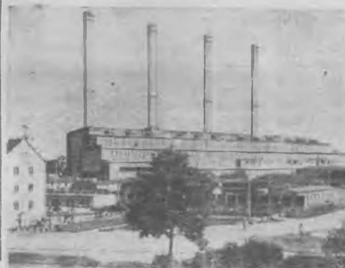
Общий вид электростанции Фокероде. На электростанции, построенной в годы народной власти, работает 12 агрегатов общей мощностью 384 тысячи киловатт.
