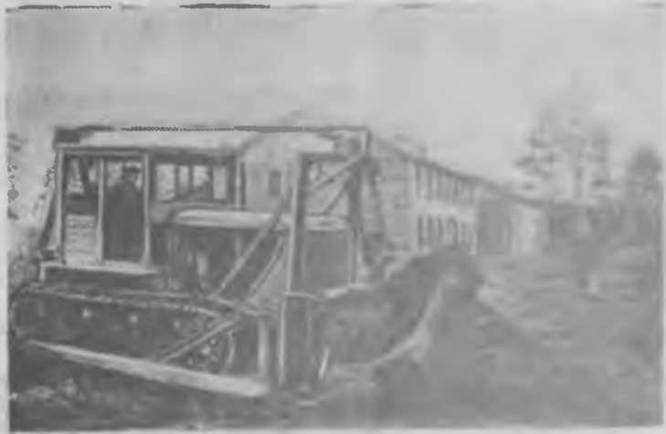
На месте непроходимых лесов и болот растет будущий город угольщиков—теперь горняцкий поселок Булаша. На строительстве работают мощные бульдозеры канавокопатели. На снимке: канавокопатель за работой. Фото А. МАРТЫНОВА.
