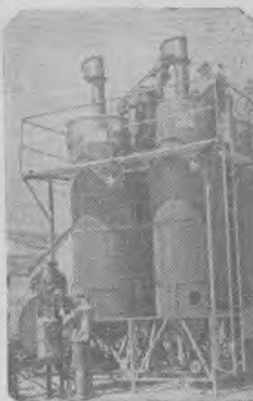
Коллектив научно-исследовательского института пищевой промышленности предложил новую конструкцию зерносушилки. Для подогрева воздуха зерносушилки используется переработанный старый локомотив, который нагревает в час 40 тысяч кубометров воздуха до 130 градусов. Остальные узлы зерносушилки приводятся в действие дизельным мотором. Производительность агрегата 10 вагонов зерна в сутки. На снимке: новая зерносушилка.
